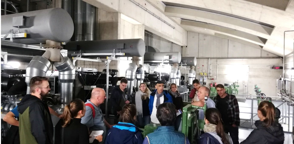
Im Hochwasserpumpwerk Johannstadt, Foto: S. Waldburger
