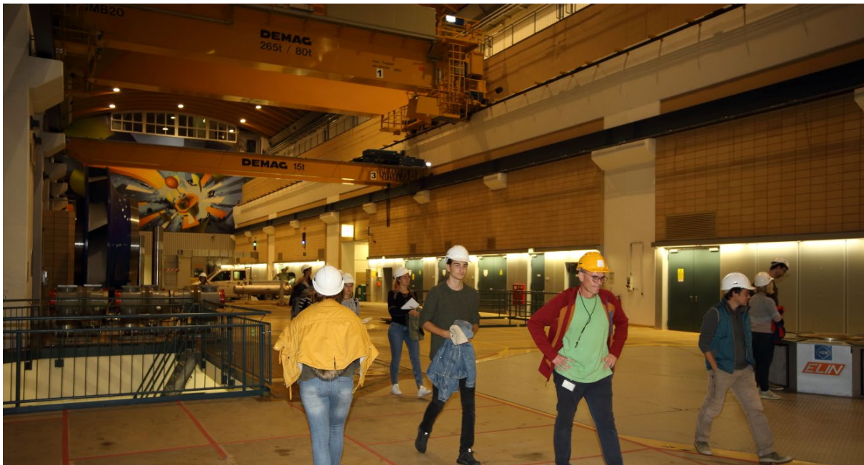
Kraftwerkskaverne, Foto: S. Knoll
