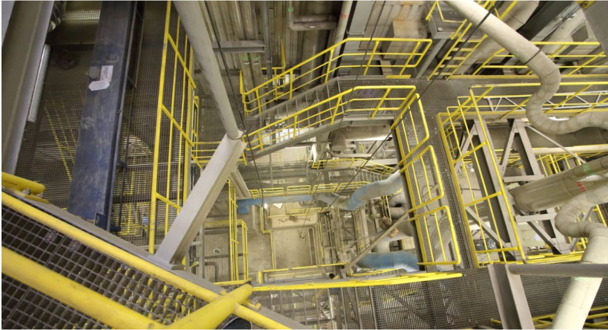
Im Inneren der MVA Zorbau, Foto: S. Knoll
