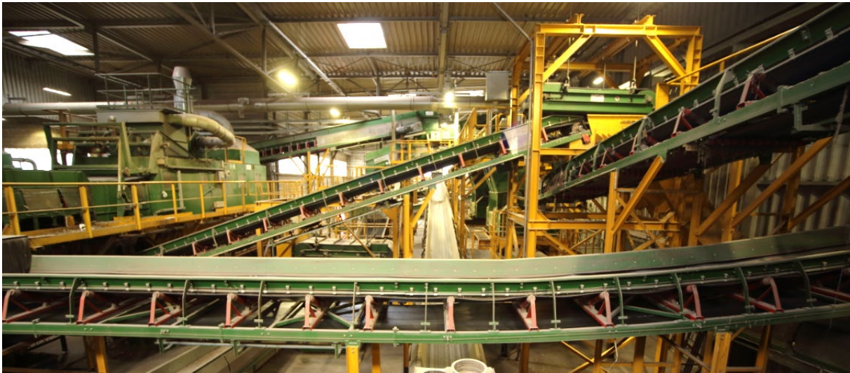
Anlagen zur Sortierung/Klassierung des Hausmülls, Foto: S. Knoll
