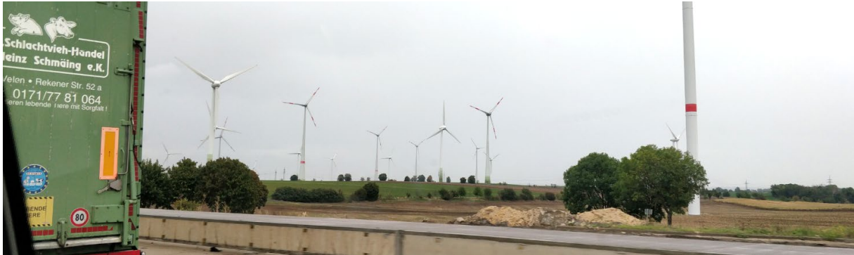
Blick auf die Energieerzeugung der Zukunft in Ostdeutschland, Foto: M. Rose
