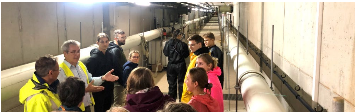
Kontrollgang der Tunnelabdichtung, Foto: P. da Silva
