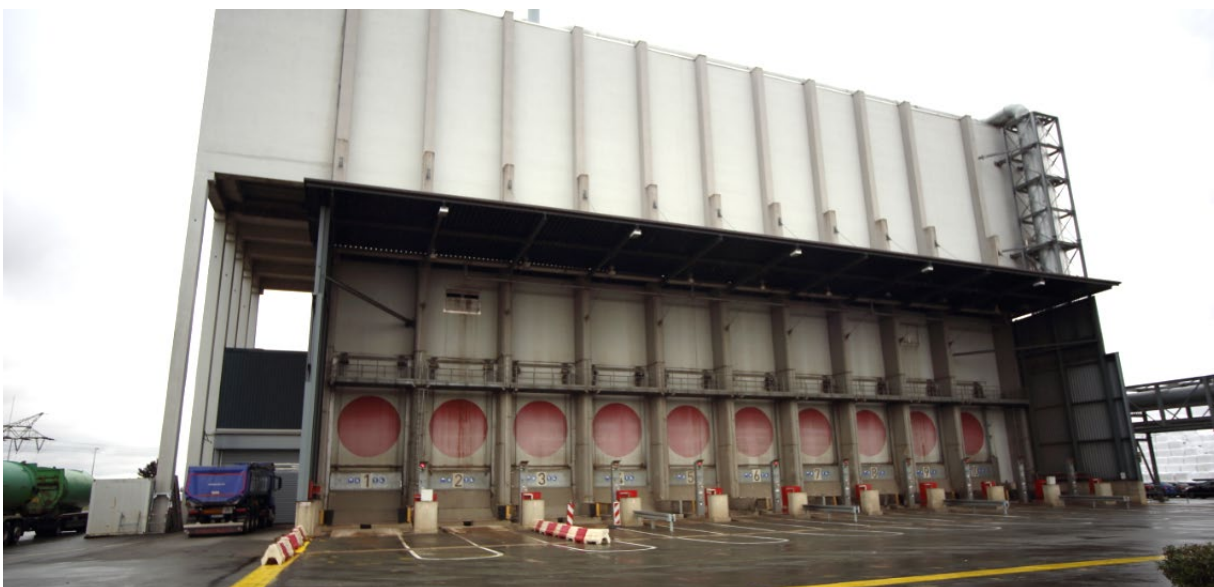
Anlieferungsportal der MVA Zorbau, Foto: S. Knoll
