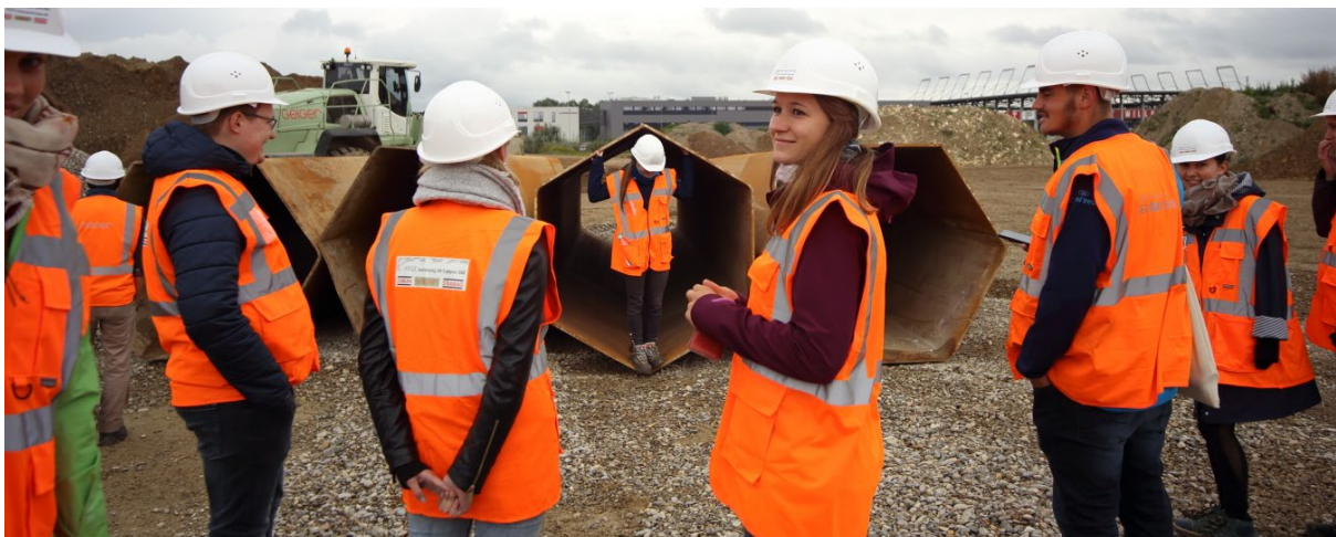
Stahlwaben für den Aushub im Wabenverbau, Foto: S. Knoll
