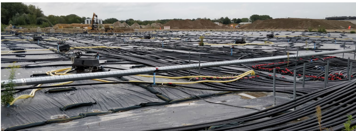
Altlastensanierung - Wetter..., Foto: F. Rose
