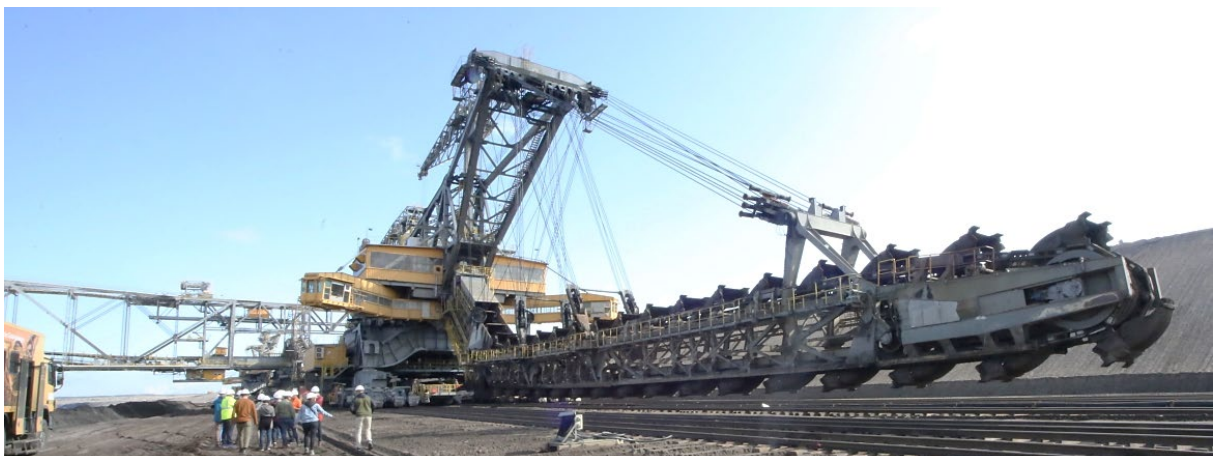
Eimerkettenbagger/Vorschnittbagger, Foto: S. Knoll
